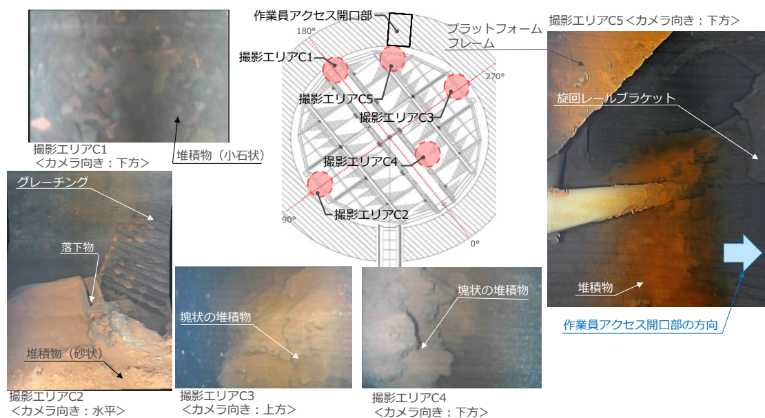
図 4.8.3-11 PCV 内部調査で撮影したペデスタル底部 [3・15]
