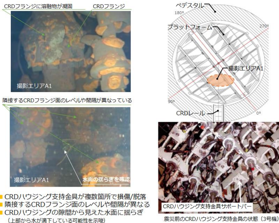
図 4.8.3-3 RPV 底部の様子 [3-15]
