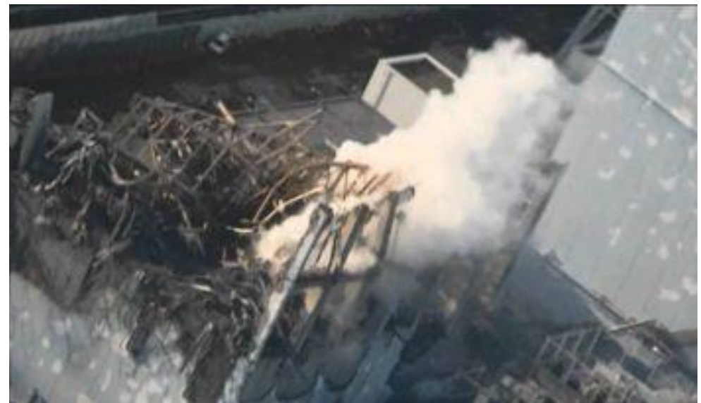
事故時の3号機原子炉建屋の様子
