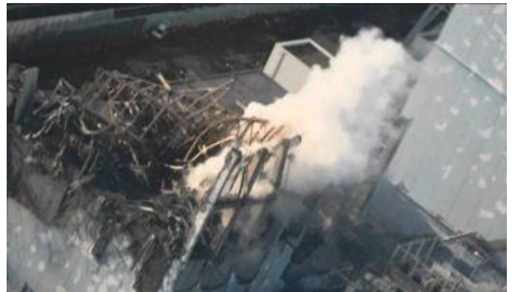
事故時の3号機原子炉建屋の様子
