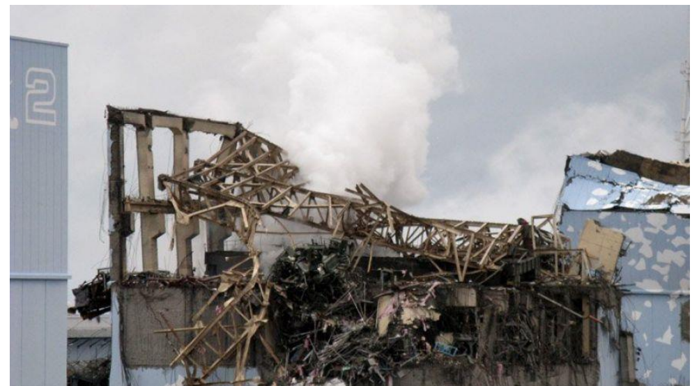
事故時の3号機原子炉建屋の様子
