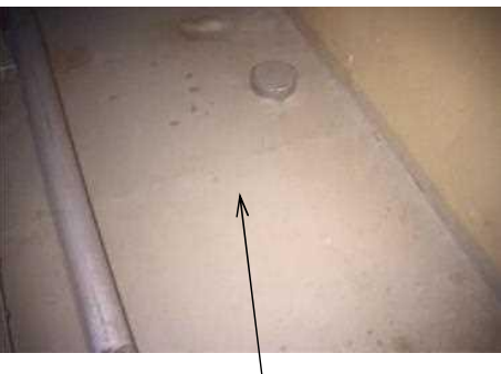
写真③：東側通路（通路中央付近）
