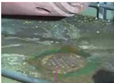
写真⑥：2013年調査時 床ドレンファンネル状況
