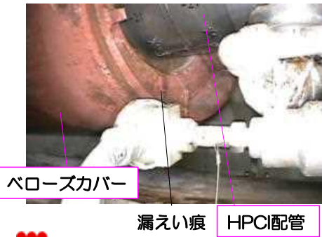
写真①：X-53ベローズカバー接続部
