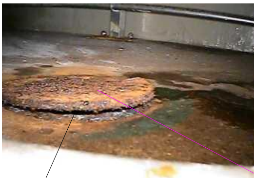
写真④：床ドレンファンネルの浮き上がり状況
